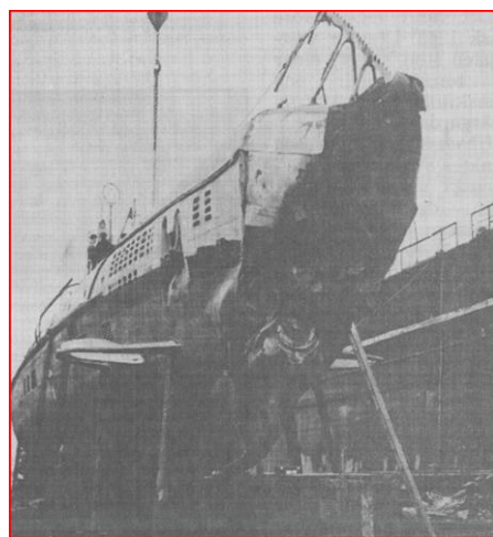
Efter explosionen rände Ulven in i bergbotten, varvid förskeppet trycktes in och kilades fast
