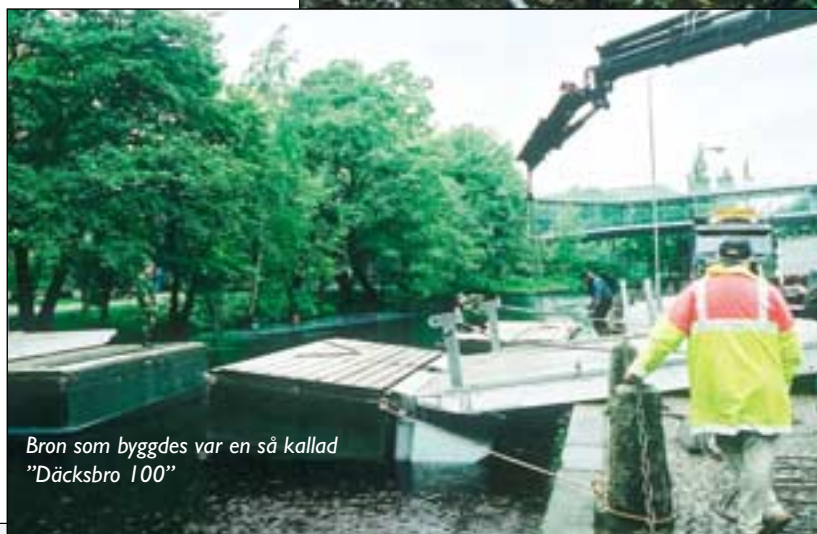
Ing2 byggde bro i centrala Göteborg
